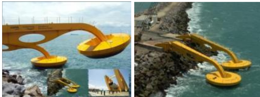
Figura N° 8: Planta piloto en Puerto Pecem, Brasil. Fuente: Catálogo Energías del Mar, 2014
