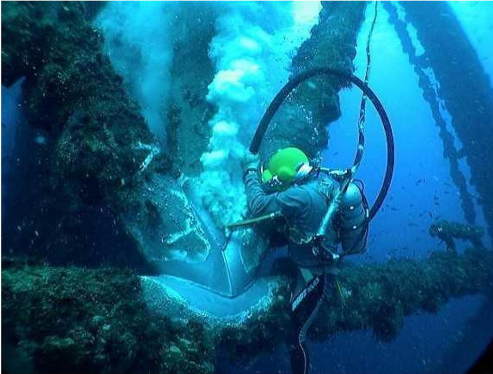
Ilustración 29. Limpieza de estructura submarina en plataforma.
