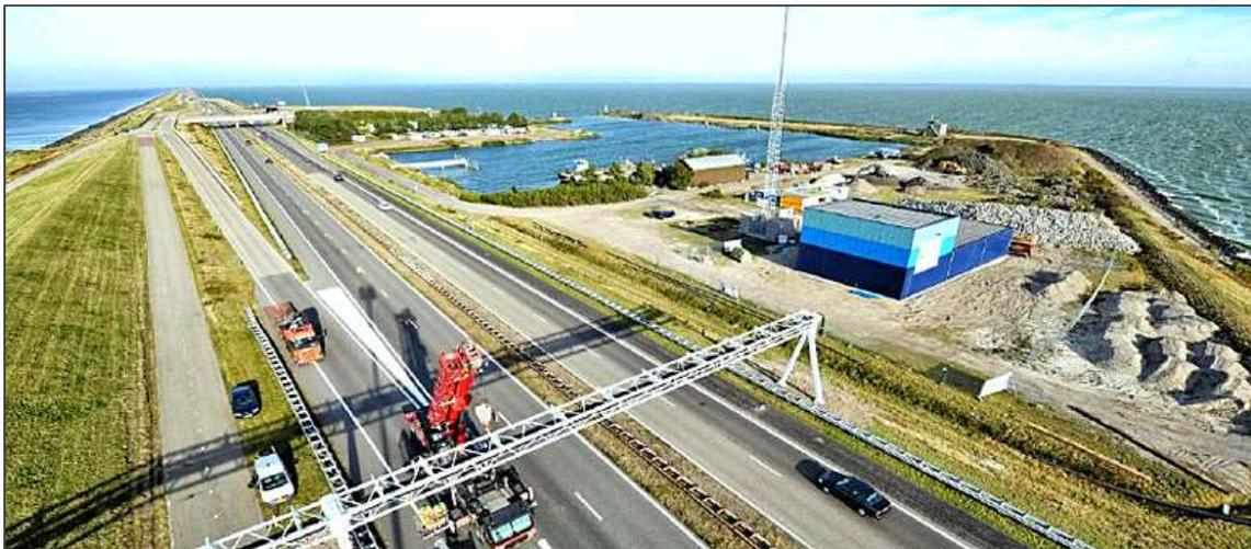
Figura 46. Planta piloto de Afsluitdijk (Países Bajos), la primera planta RED del mundo. Fuente: <http://www.dutchwatersector.com/uploads/2014/11/dws-redstack-pilot-afsluitdijk-770px.jpg>
