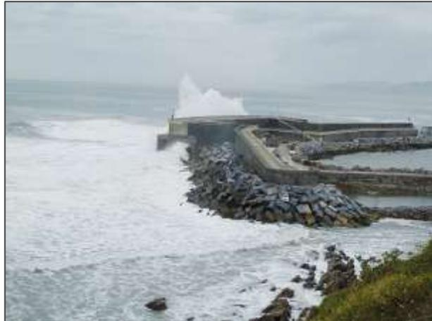
Figura 27. Planta OWC en el rompeolas del puerto Mutriku en País Vasco, España. (Power Technology, s.f.b).
