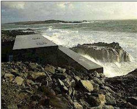
Figura 23. Planta LIMPET OWC en Islay, Escocia. (Centre for Renewable Energy Sources, 2006).
